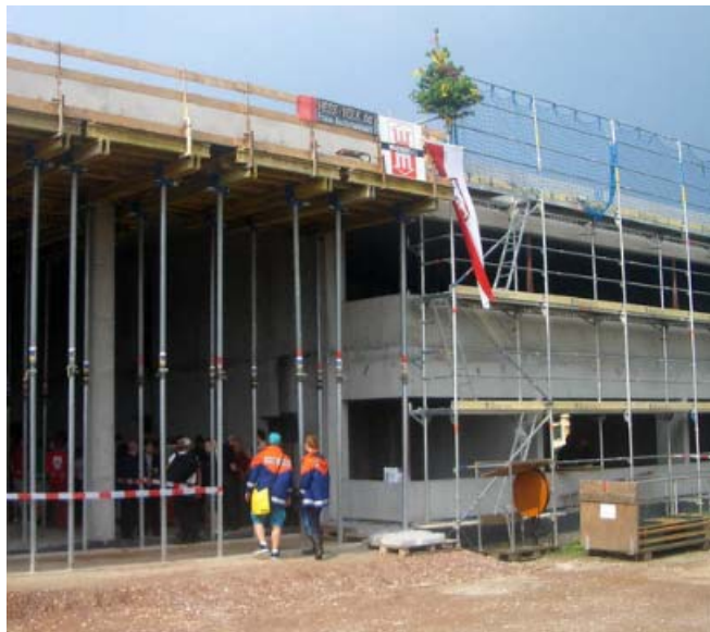
Der Rohbau für das neue Feuerwehrgerätehaus im Marcher Zentralgebiet steht.
