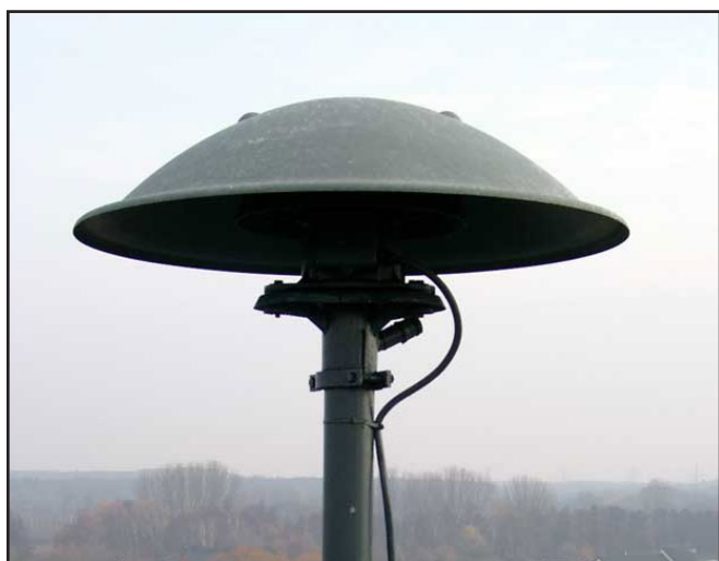
Links: Die mechanisch-pneumatische Motorsirene vom Typ SIEMENS E-57 war in Deutschland lange Zeit die meist verwendete Einheitssirene. Rechts: Elektronische Sirene vom Typ HÖRMANN ECI 600.
